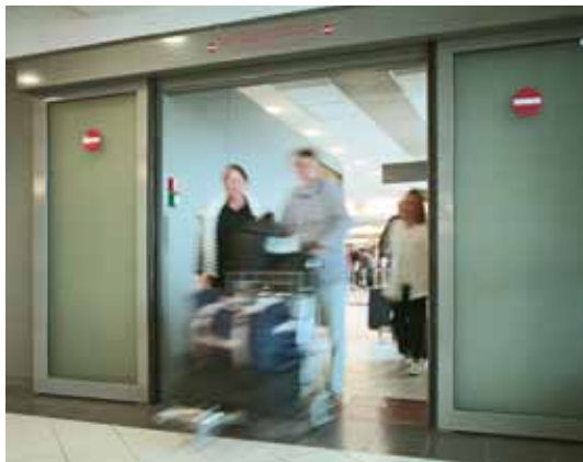
Porte coupe-feu automatique, récupération des bagages, LYS
