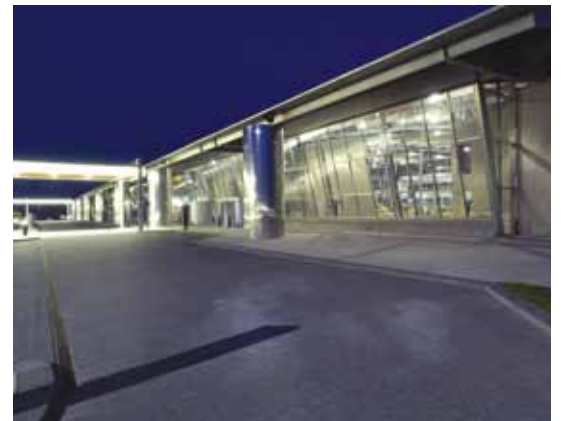
Portes automatiques, façade, BLL
