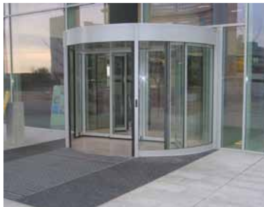
Porte tournante à 2 vantaux avec porte automatique coulissante intégrée, BLL
